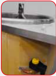
Valvula para el control de enfriamiento de la mitad de la bañera
